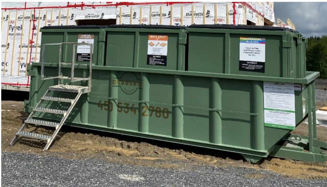
Installation typique d'un conteneur compartimenté sur un chantier résidentiel
