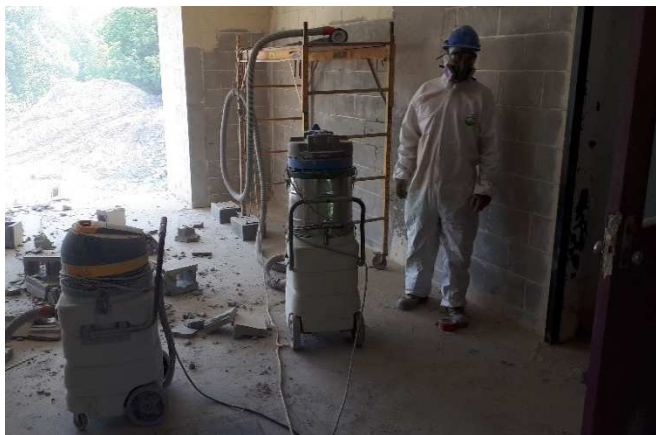
Photos 4 et 5 Travaux de décontamination
