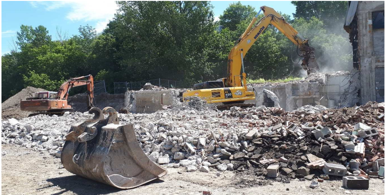
Photo 9 Concassage du béton : la pelle hydraulique en action
