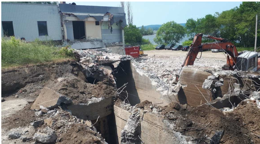
Photo 8 Aperçu des réservoirs pendant la démolition
