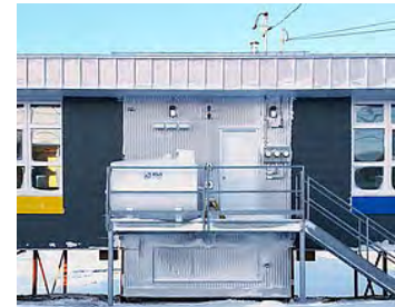
Figure 8 : Installation de chauffage au mazout
