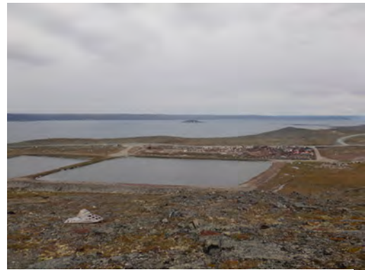
Figure 23: Étang d'épuration de Kangirsuk et LEMN derrière
