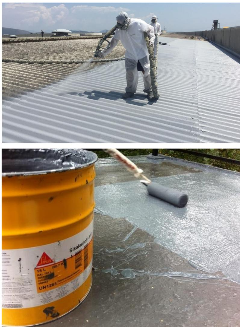
**Figure 12: Système de membranes d'application liquide à froid**
