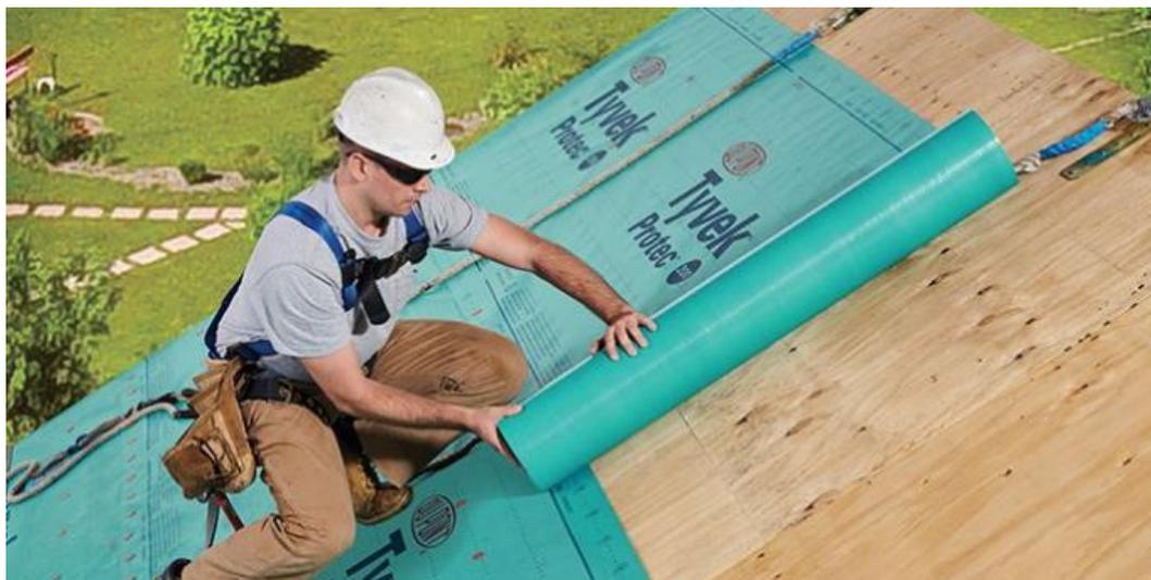
**Figure 10: Installation d'une sous-couche synthétique**
