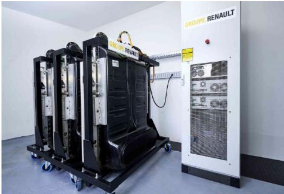
**Figure 21** Stockage d'énergie stationnaire par d'anciennes batteries de VÉ (source : Groupe Renault)
