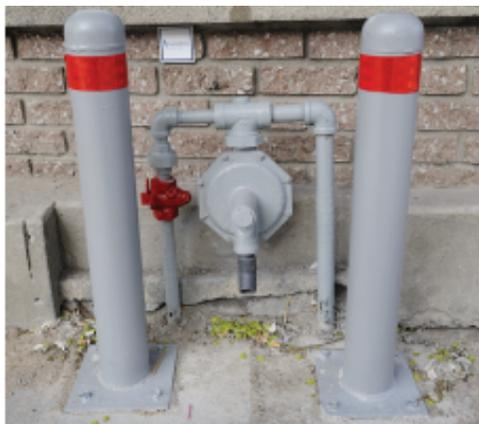
**Figure 23** Poteaux de protection pour les équipements gaziers (source : energir.com)
