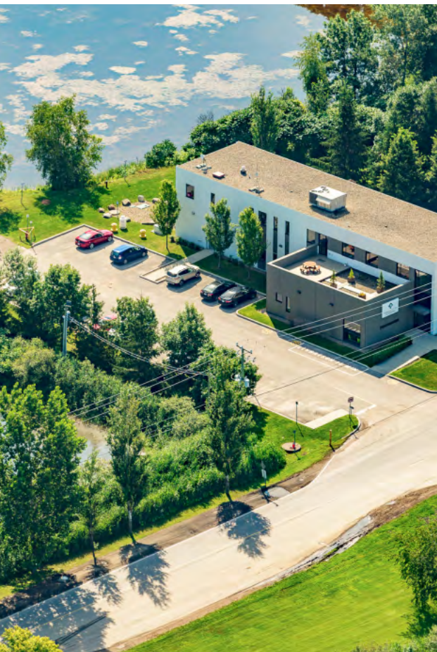
Complexe Enviro Connexions (Terrebonne)
