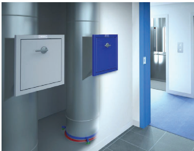
Figure 21: Portes des chutes à déchets où des dispositifs de contrôle d'accès pourraient être installés [9]
