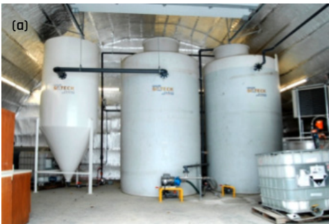
Figure 2 : Équipement connexe à la biométhanisation in situ à la Fromagerie Blackburn : (a) cuves de traitement du digestat liquide après la méthanisation et décanteur, (b) chaudière et (c) bâtiment. (Photos : Fromagerie Blackburn)
