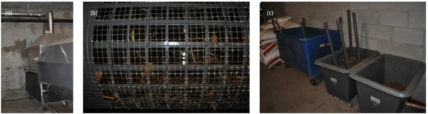
Figure 6 : (a) À la sortie du composteur, une hotte aspire l'air vers l'extérieur de l'édifice. (b) En dessous de la hotte, un tamis intégré sépare les résidus grossiers. (c) Ces résidus grossiers ainsi que le compost recueilli sont entreposés dans des bacs (respectivement gris et bleus sur la photo), dans lesquels on place des tuyaux perforés pour assurer une aération passive durant la maturation. (Photos : Louise Hénault-Ethier)
