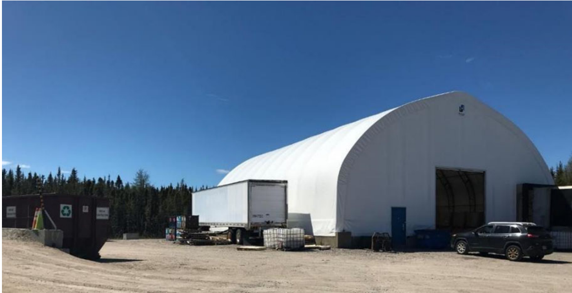
Figure 3 : Centre de transbordement des matières recyclables situé à Havre-Saint-Pierre
