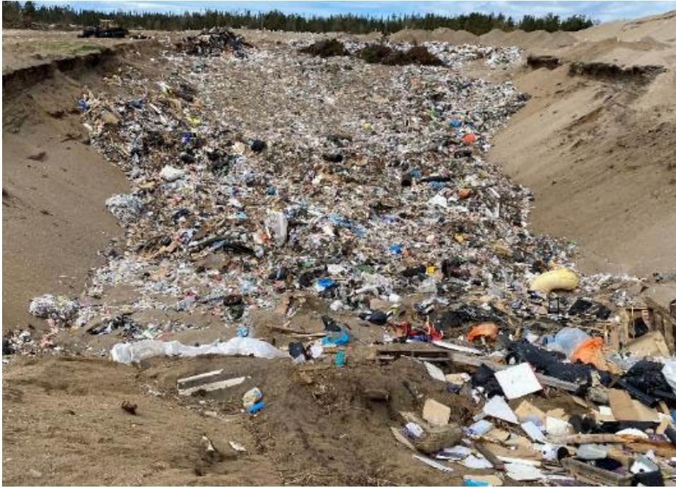
Figure 6 : Tranchée d'enfouissement des matières résiduelles à Longue-Pointe
