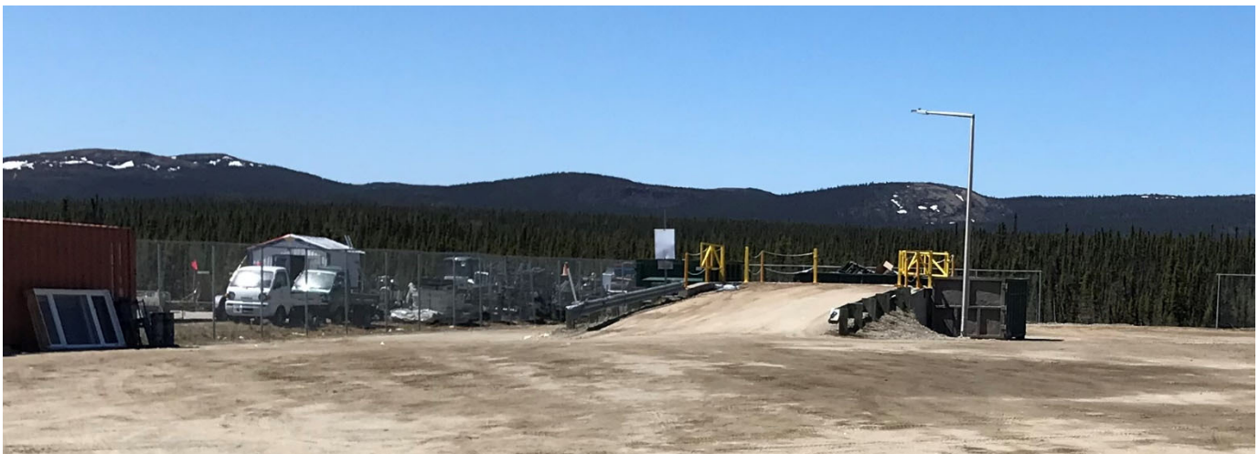
Figure 5 : Plateforme surélevée de l'écocentre de Fermont
