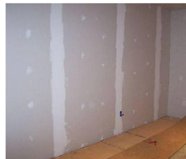
Des applications du gypse dans des activités de construction, source : Creative Commons, author Amaxson
